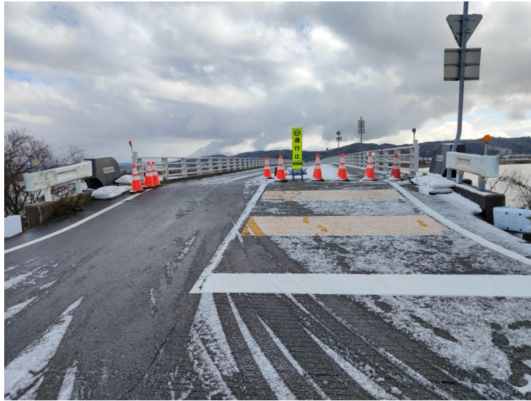
写真8 北側（河北潟側）橋台付近の状況
