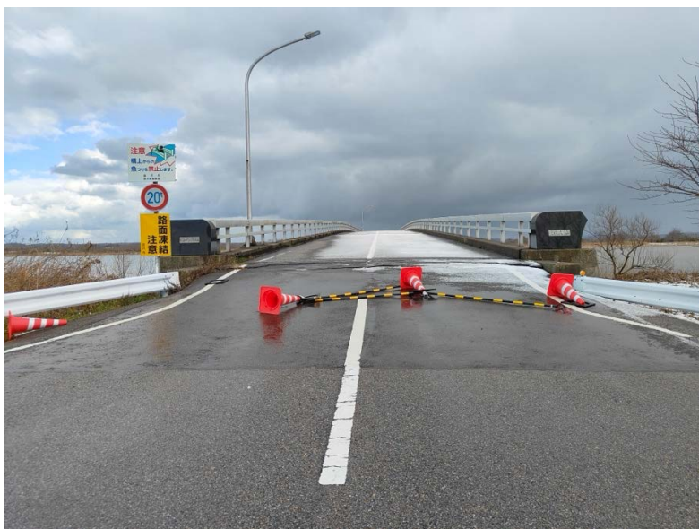
写真1 西側橋台付近の状況（目立った損傷なし）
