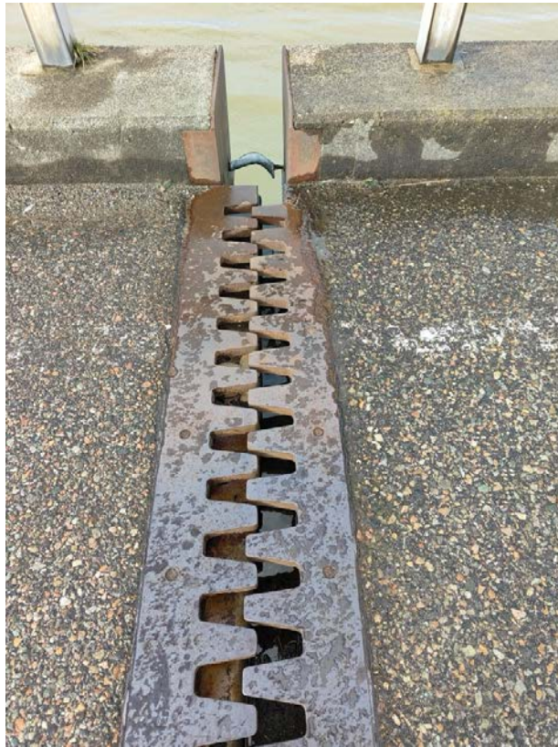
写真3 橋脚上のジョイント部（開いているジョイントが複数確認された。地形は全体として伸びていると考えられる。）
