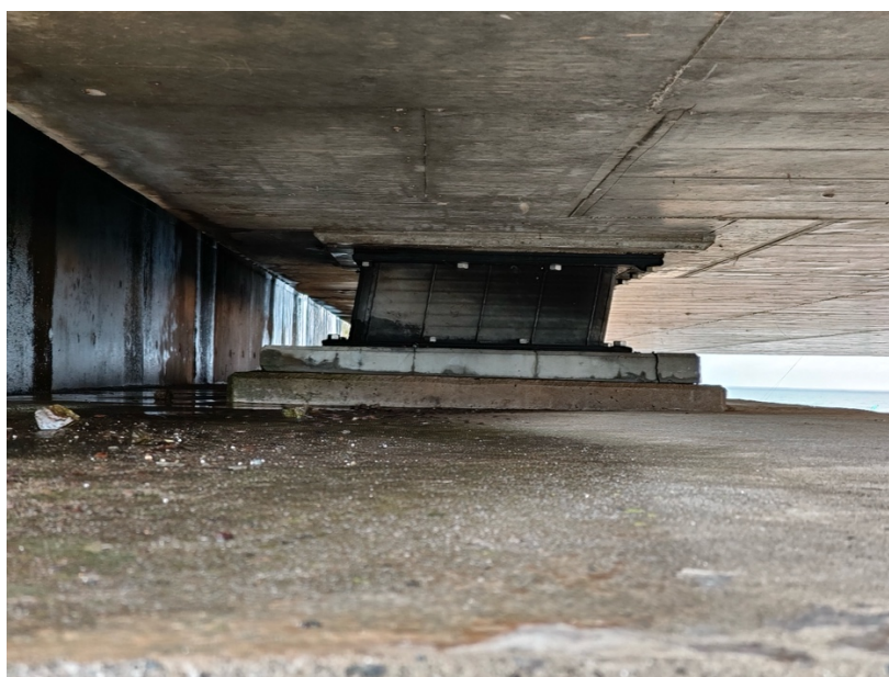
写真13 左岸側橋台の支承部（やや右側に傾いている）
